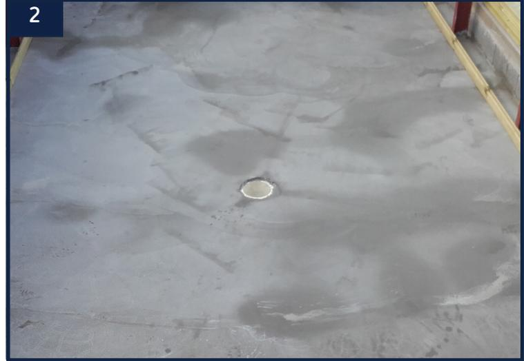
1 Avant de couler la dalle béton, positionnez votre bonde de fond et le tuyau d'évacuation au centre du bassin. Scellez-le à l'aide de béton afin qu'il ne bouge pas lorsque vous allez couler la totalité de la dalle. Attention, veillez à ce que la bonde de fond soit au même niveau que votre ragréage.
